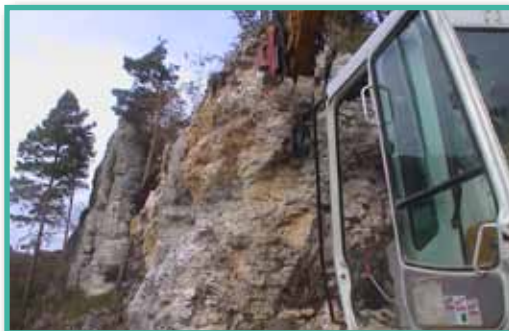
Felssicherung an Steilböschung mit temporärem Schutz der darunter liegenden Straße
