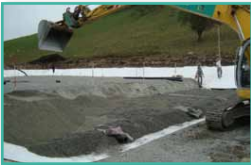
Bentonitbahn, Kies und Sandfilter werden eingebracht
