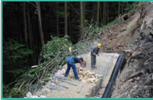
Böschungssanierung mit Gabionen in 8 m Tiefe
