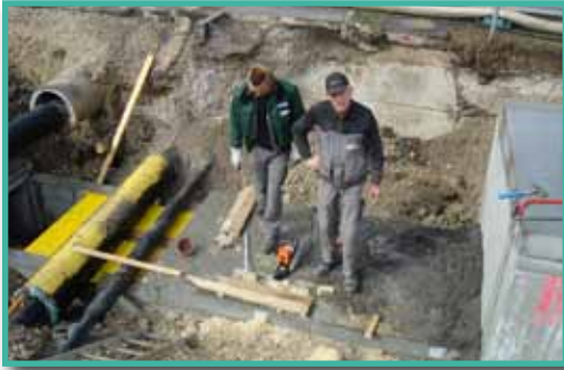
Versetzen des Einlaufbauwerks und der Rechteckprofile
