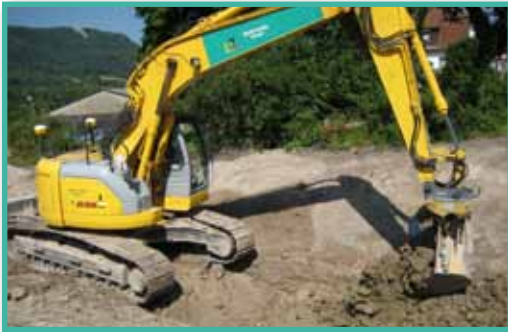
Profilgerechtes Einbringen des Lehmschlags mittels 3D-Steuerung
