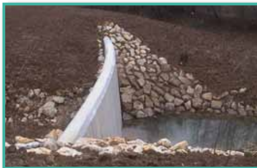
Regenrückhaltebecken mit Auslaufbauwerk
