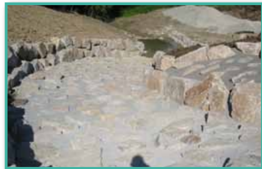
Granitsteine in Beton versetzt
