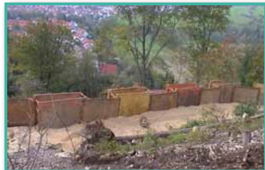
Felssicherung an Steilböschung mit temporärem Schutz der darunter liegenden Straße
