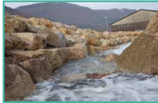
Naturnahe Böschungsbefestigung mit Jurakalk-Wasserbausteinen
