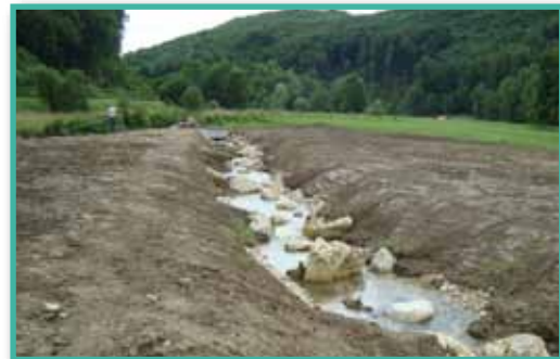
Fertiggestellter Fischaufstieg mit Riegeln und Störsteinen
