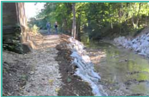
Uferbefestigung mit Wasserbausteinen (Dolomit-Kalksteine)
