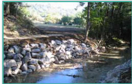
Uferbefestigung mit Wasserbausteinen (Dolomit-Kalksteine)
