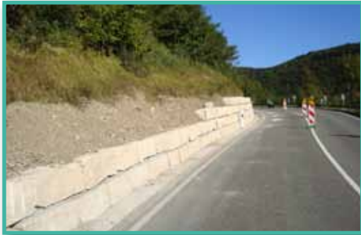
Hangsicherung mit Weißjura-Blocksteinen
