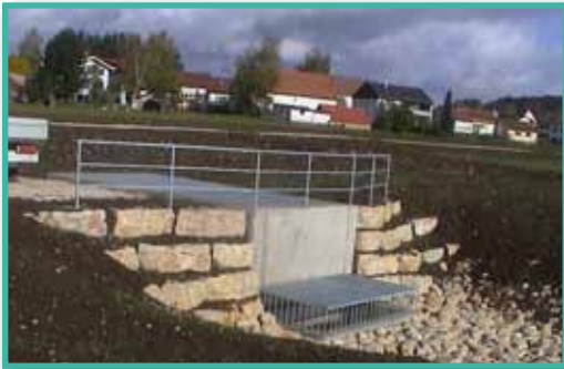
Versickerungsbecken mit Tiefenbohrungen über 20 m
