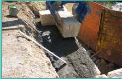
Sanierung der Stützmauer mit Jurakalk-Blocksteinen
