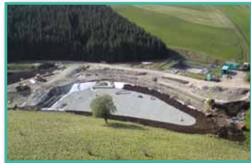
Parallel dazu werden Böschungen fertiggestellt
